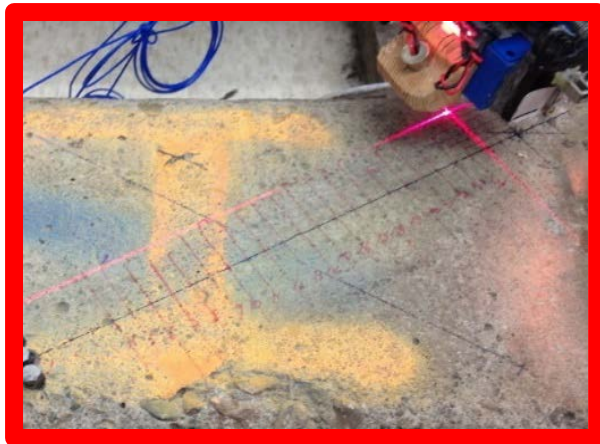
R1 : no damage
