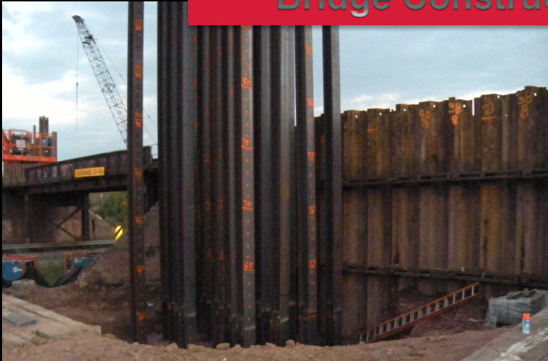
110 ft long piles (HP 14x89)
